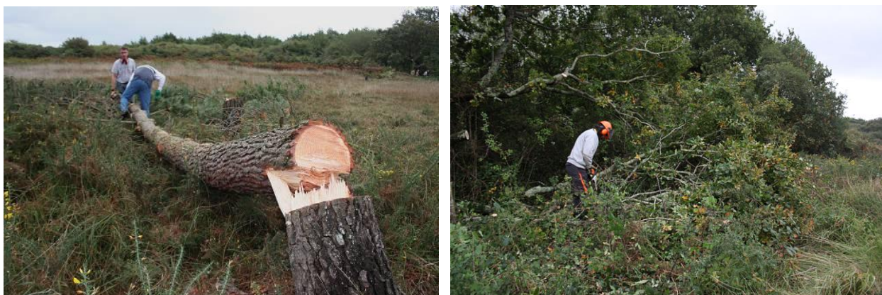
Photos 18 et 19 : Travaux menés à Kercadoret en 2013 ; Elagage et débroussaillage pour faciliter le passage du tracteur hors des zones sensibles et tronçonnage des pins maritimes ; Lionel Picard, GREZIA
